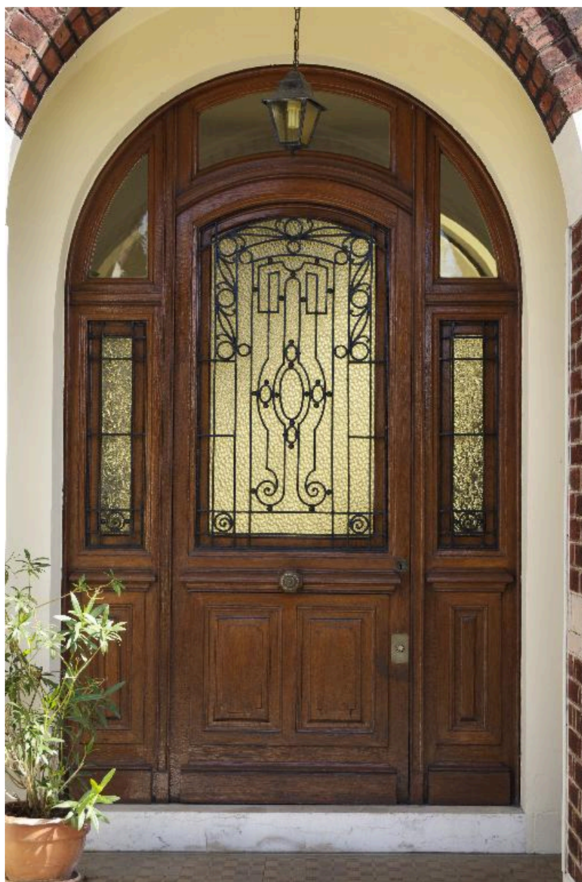
Porte d'entrée principale, détail.
