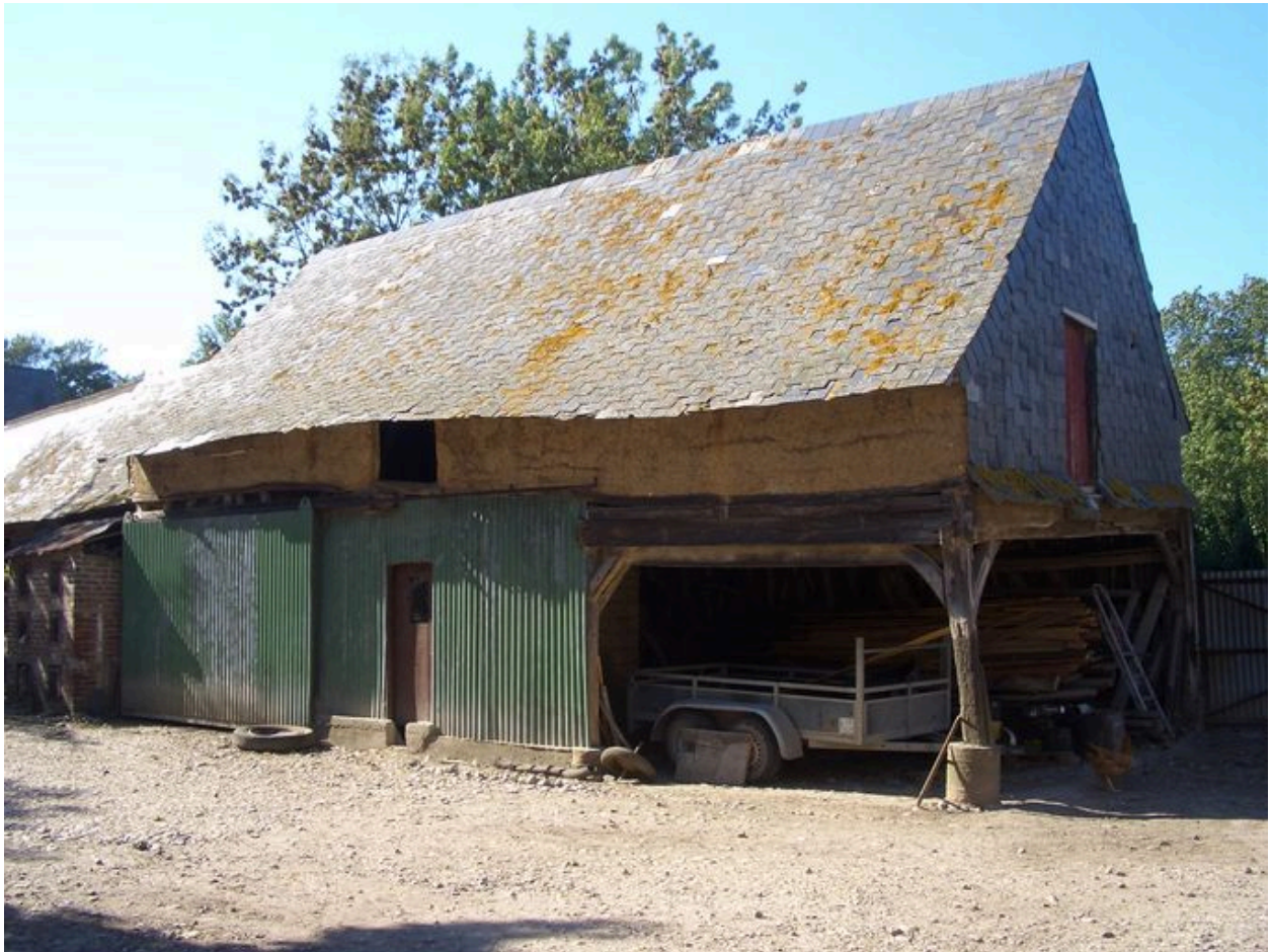
Vue du grenier sur pilotis servant également de charreterie.
