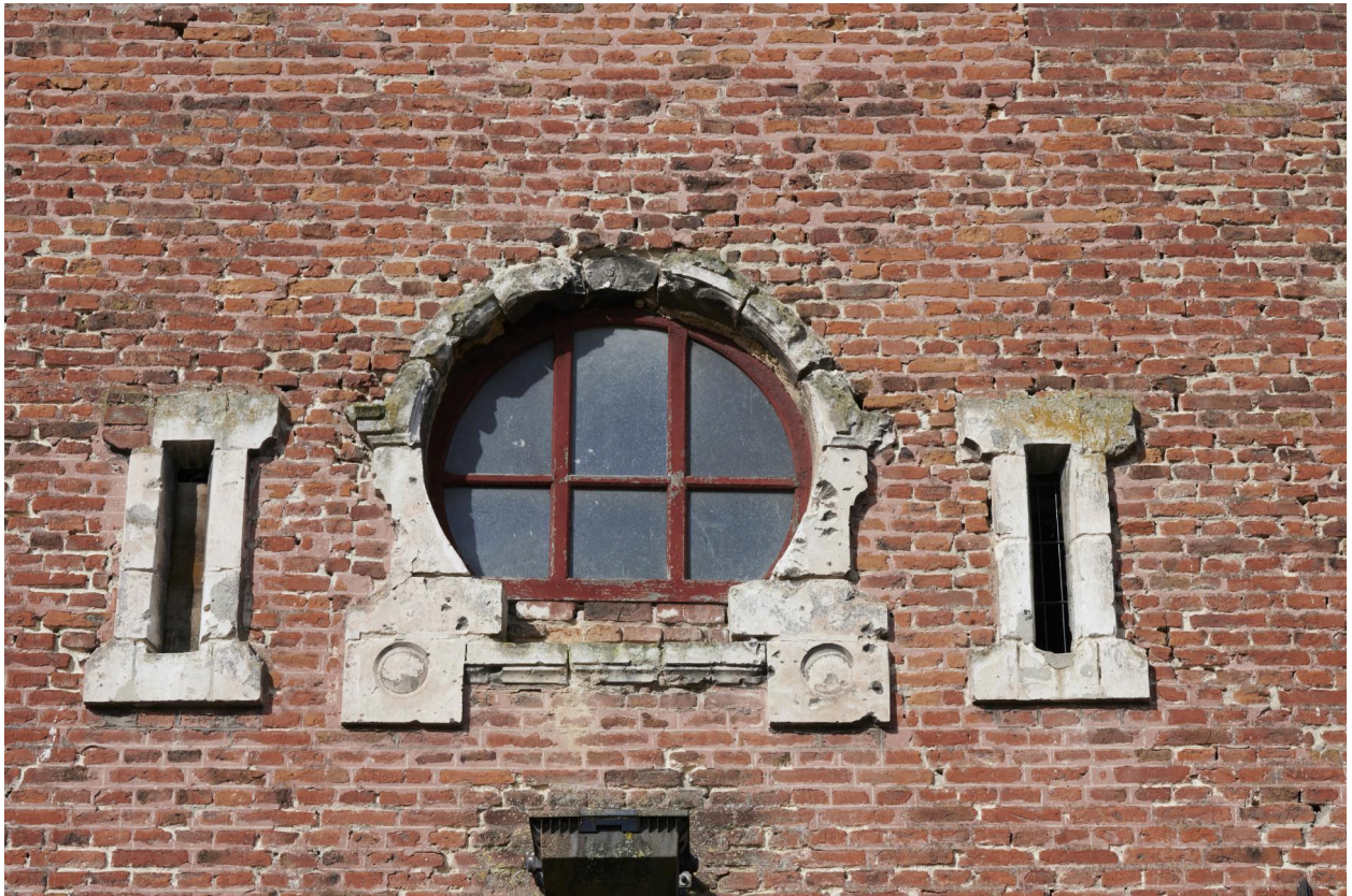
Tour-porche. Détail du médaillon circulaire donnant sur la cour intérieure.
