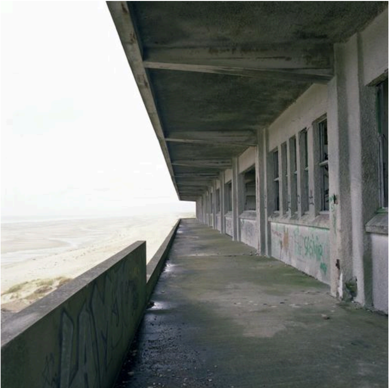
Élévation antérieure, galerie de cure d'un des étages, vue en enfilade.
