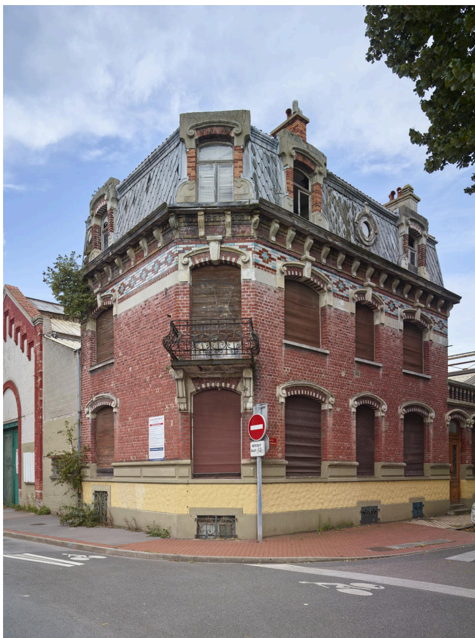
Vue vers le nord-est de l'ancien logement patronal.
