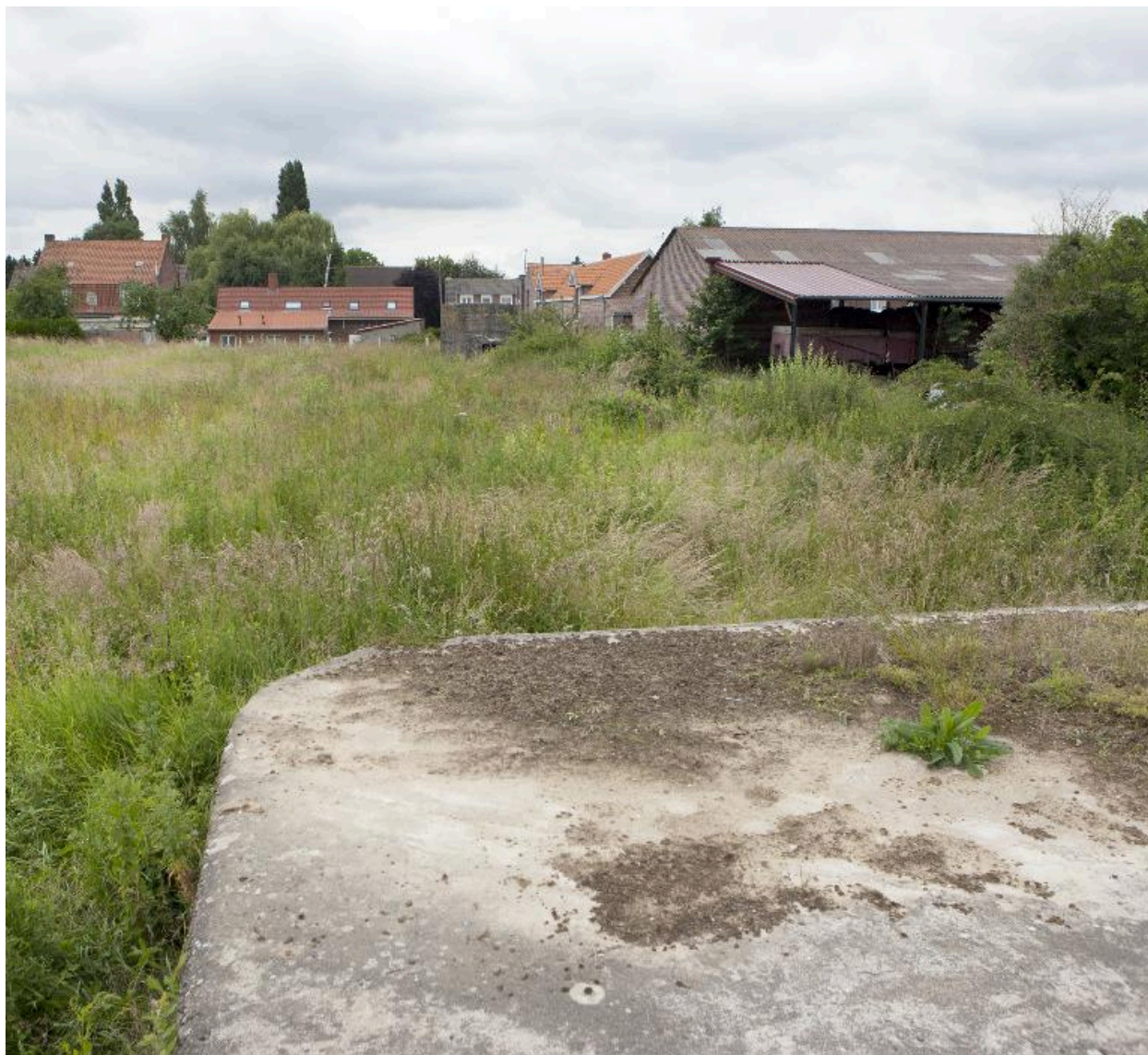
Guérite casematée (Bat. A), dans le fond, depuis le couverture de la casemate à personnel (Bat. B)
