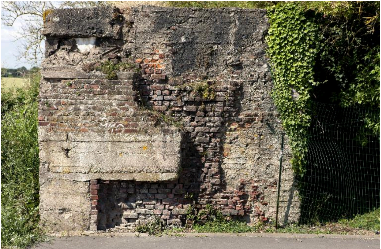
Elévation sur la rue de Sequedin
