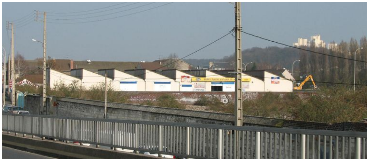
Vue générale des ateliers en sheds construits en 1961 et 1971.
