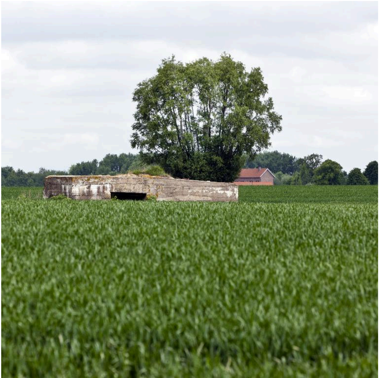
Élévation antérieure, vers le nord-ouest
