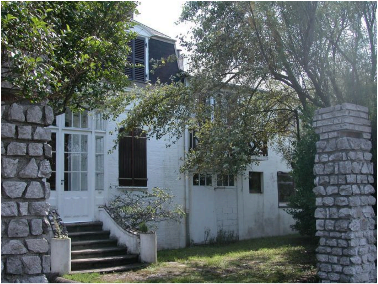
Détail de l'extension latérale.
