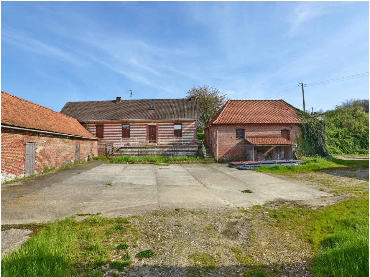
Vue générale depuis la cour du logis.
