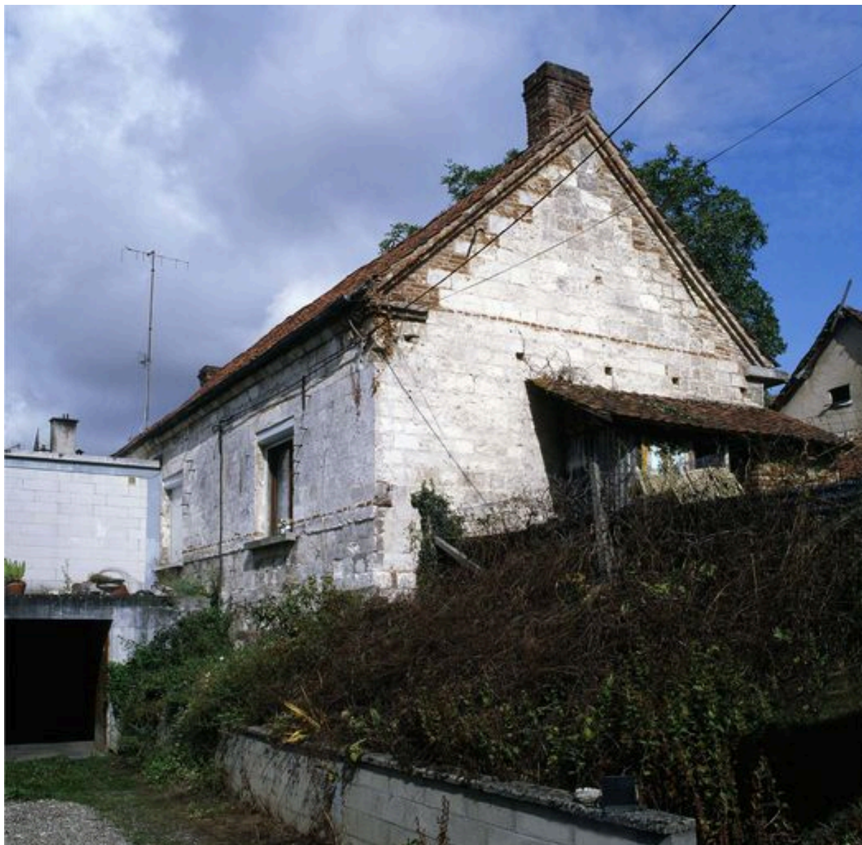
Vue du pignon extérieur du logis.
