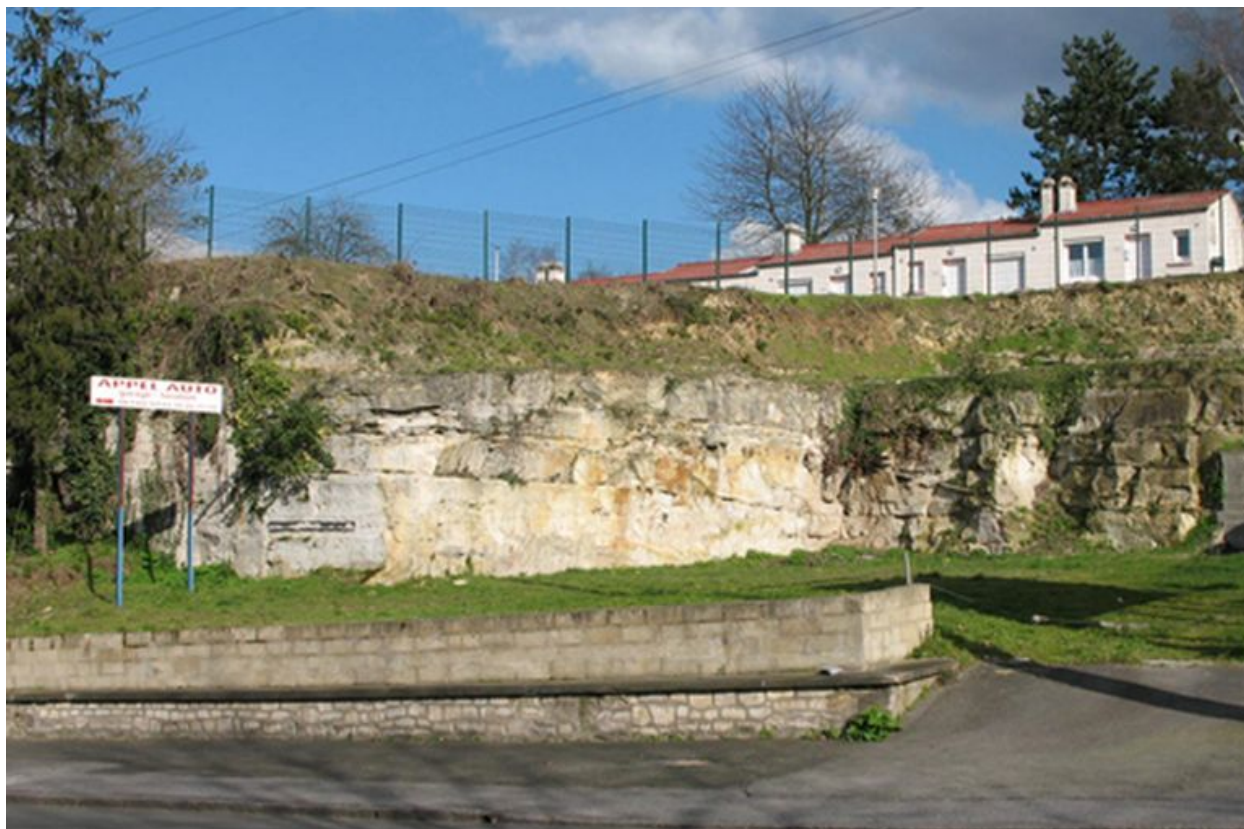
Front de taille le long de la rue Léon-Blum (ancienne cavée de Paris).
