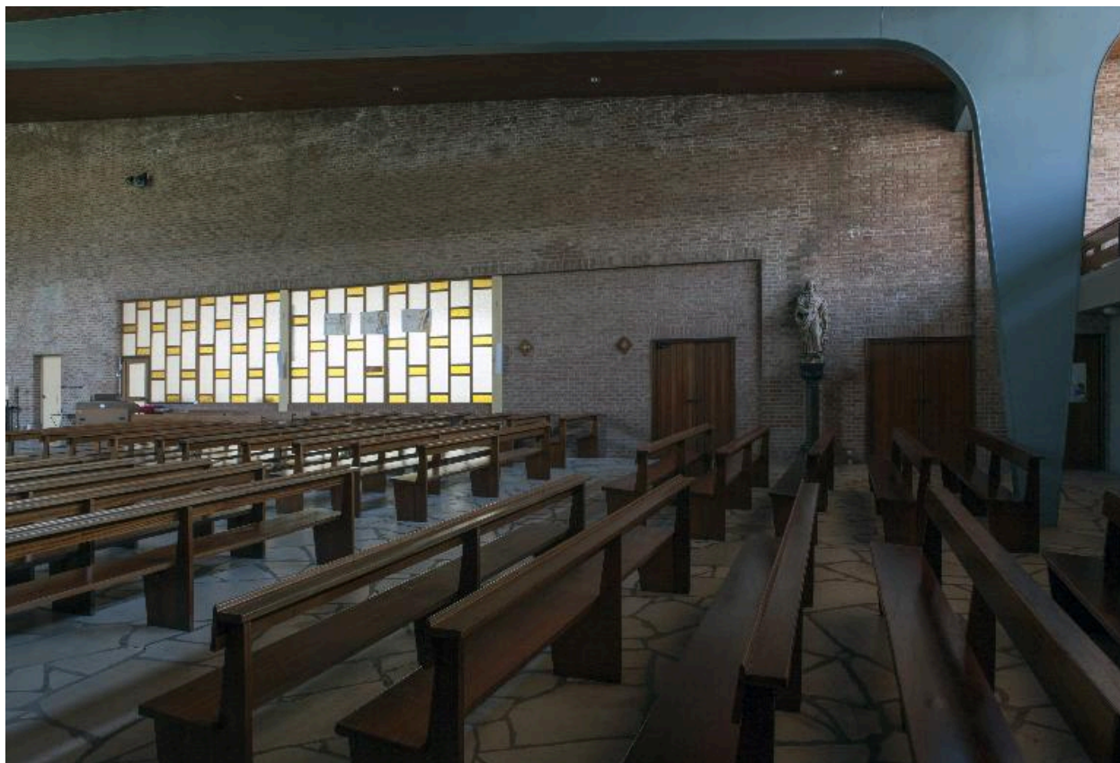
Vue intérieur vers le côté droit.
