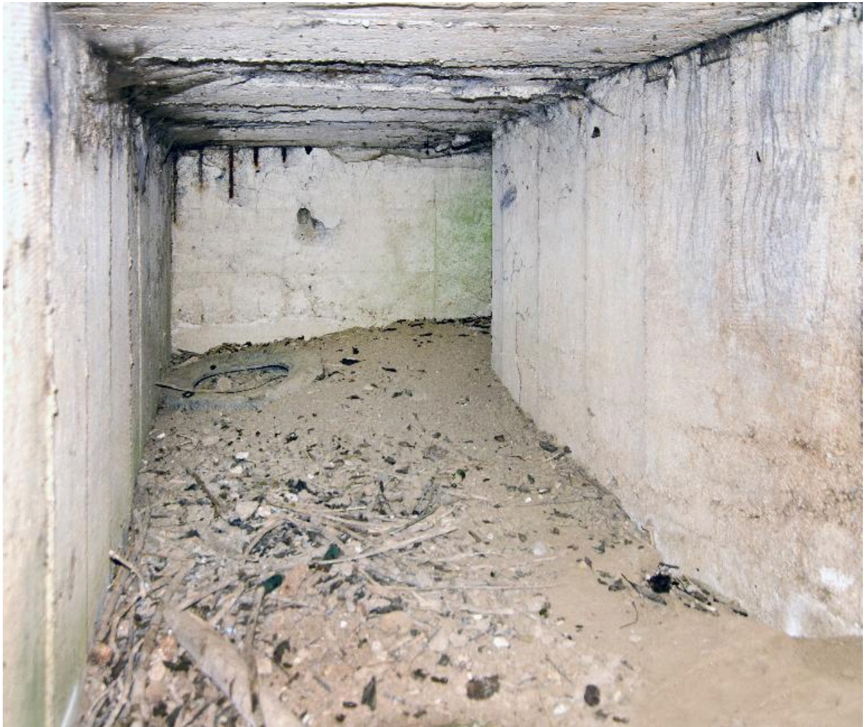
Couloir d'entrée sud, en grande partie comblée
