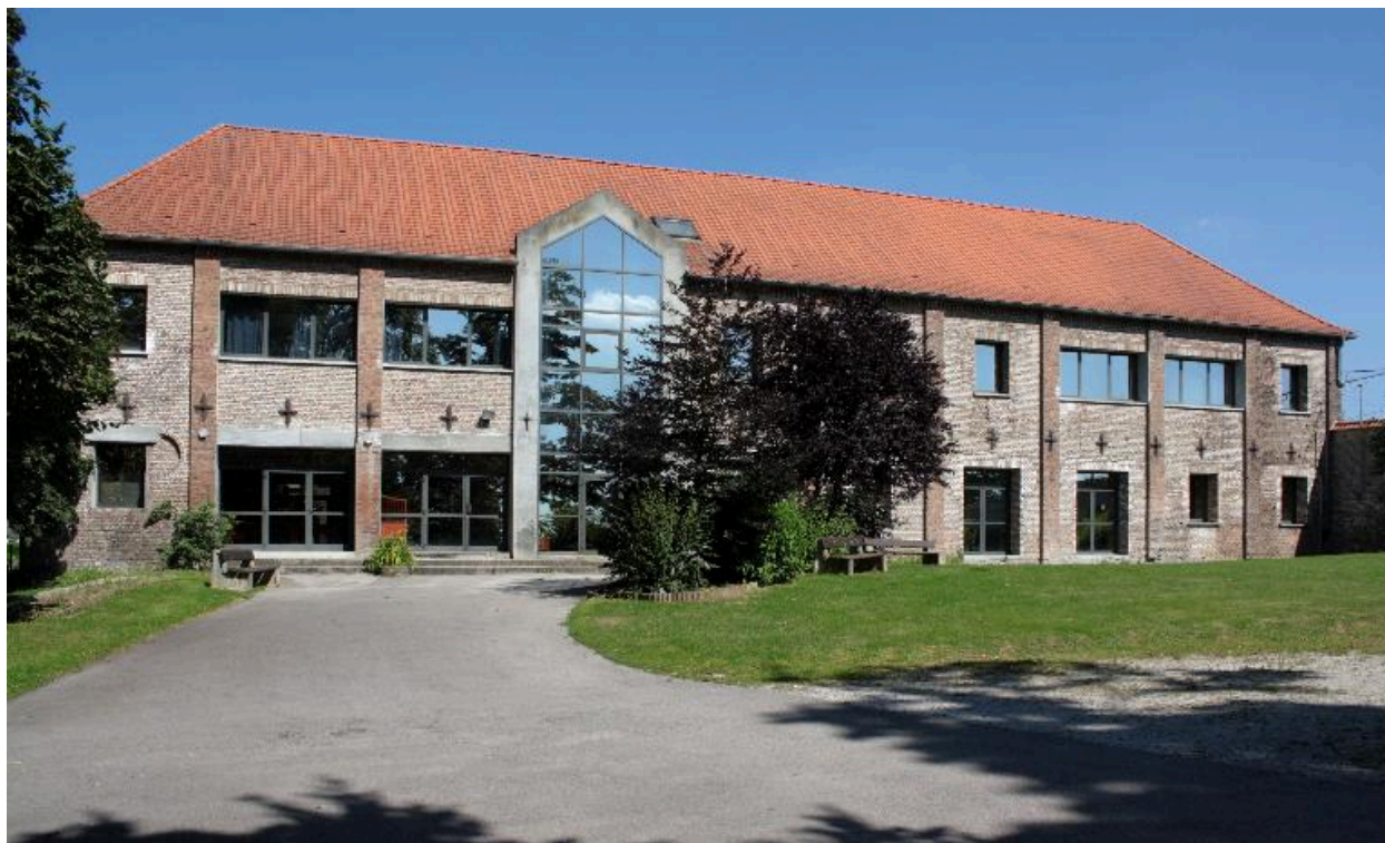
Façade extérieure des anciennes étables à vaches et écuries transformées en restaurant scolaire et salles de classe.
