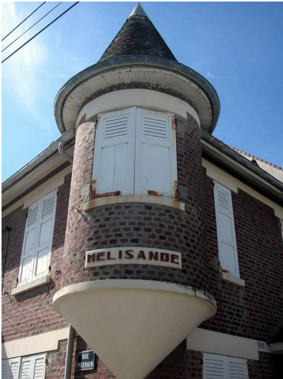
Détail de la tourelle d'angle en surplomb.
