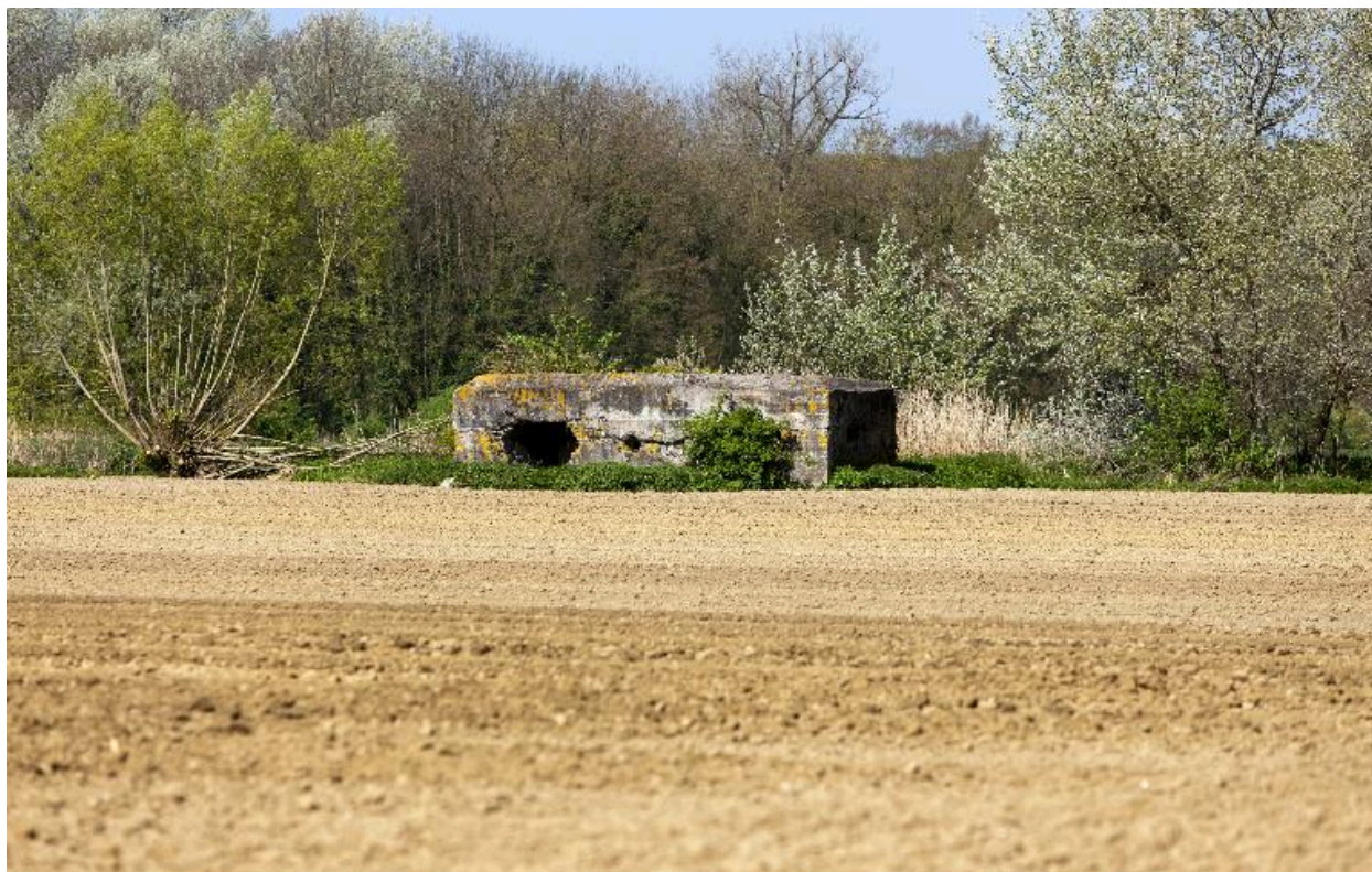
Vue générale vers le nord-ouest
