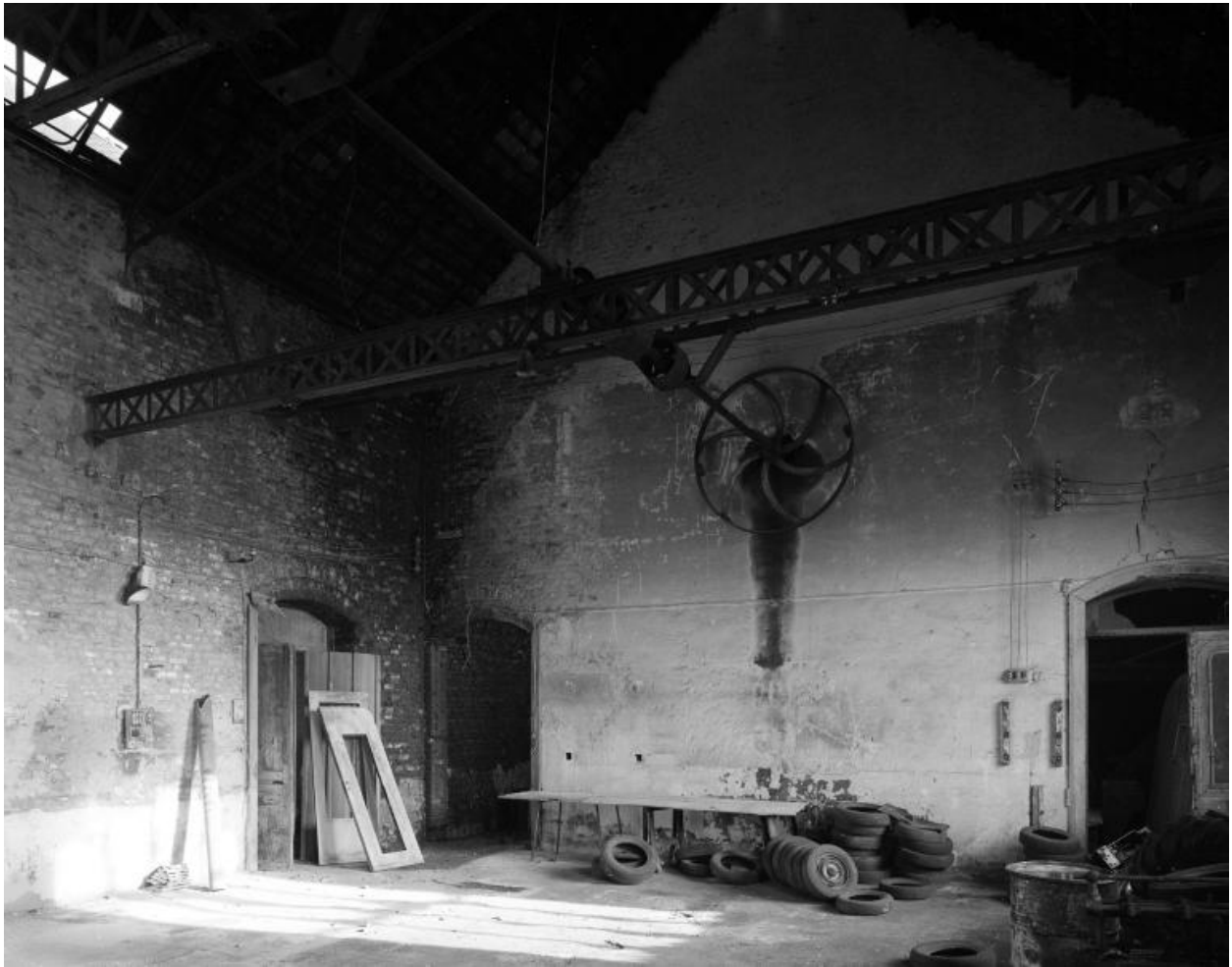
Atelier de réparation, vue intérieure.
