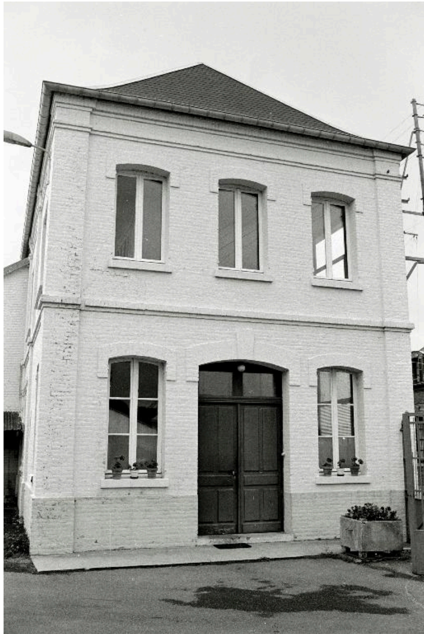
Elévation principale des bureaux, en 1990.
