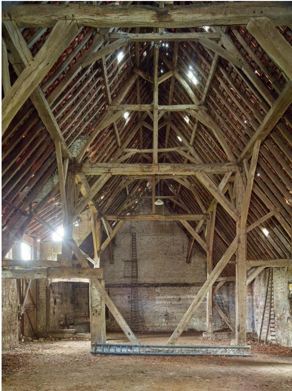
Fermes des Berceaux : grange monastique : vue intérieure orientée ouest-est.
