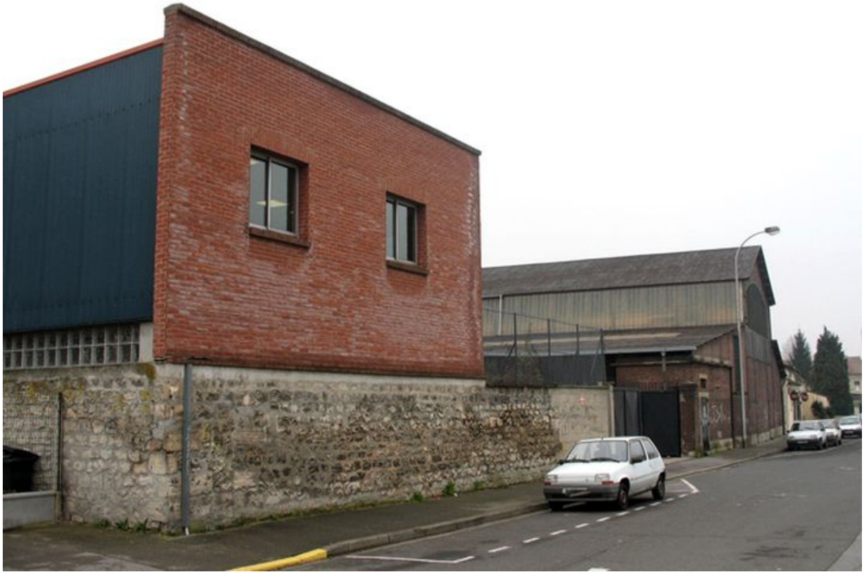
Emprise de l'usine sur la rue Michelet.
