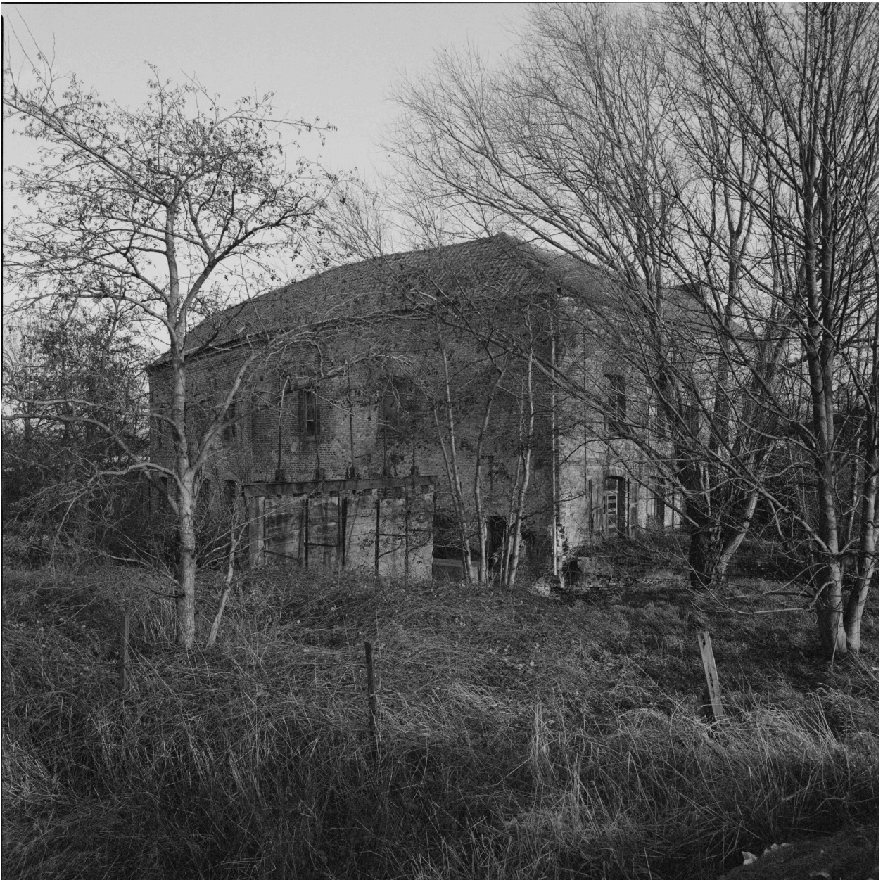
Vue générale vers l'est.
