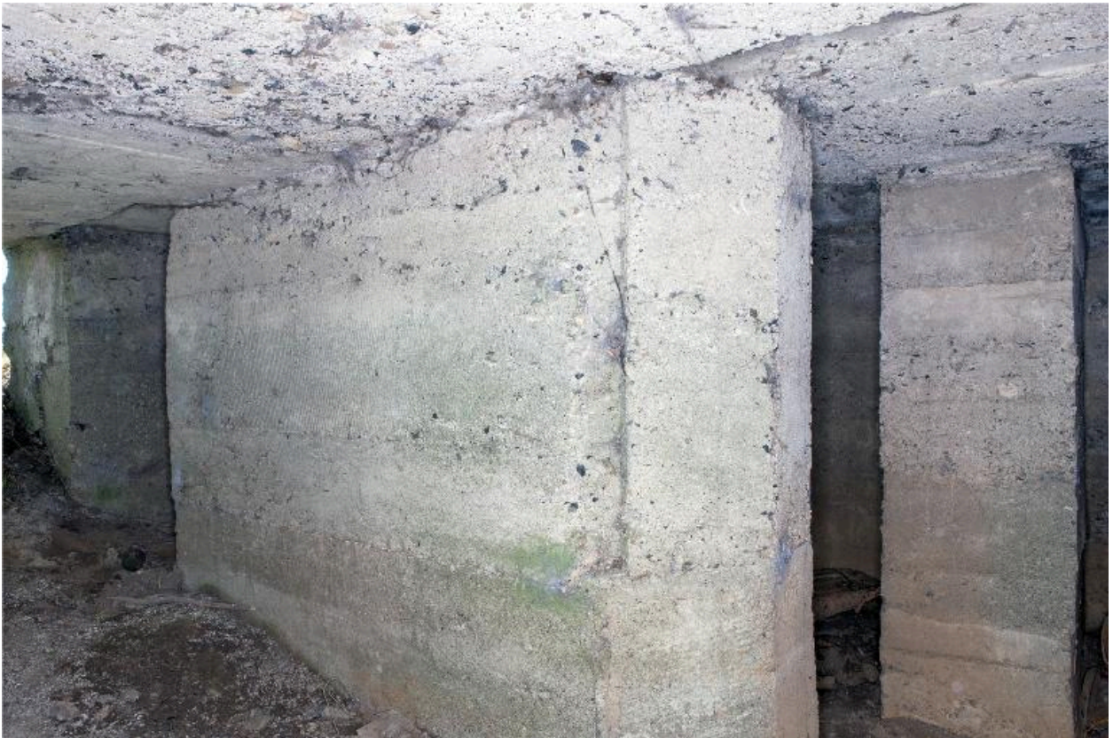
Couloir, vers l'entrée sud-est
