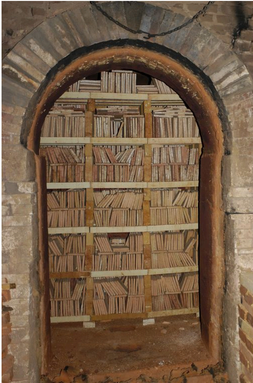
Détail de l'entrée ouverte du four de cuisson.
