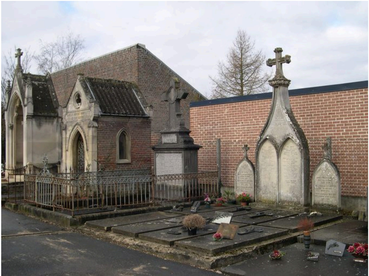
Vue générale en 2005, avant rénovation.
