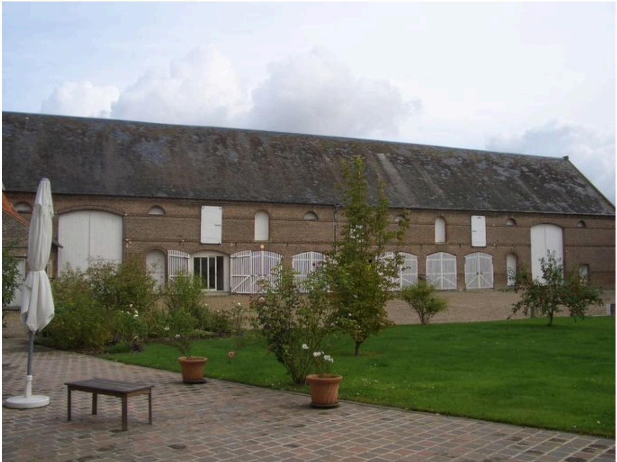
Vue des bouveries depuis la cour occupant tout le côté nord de la propriété.
