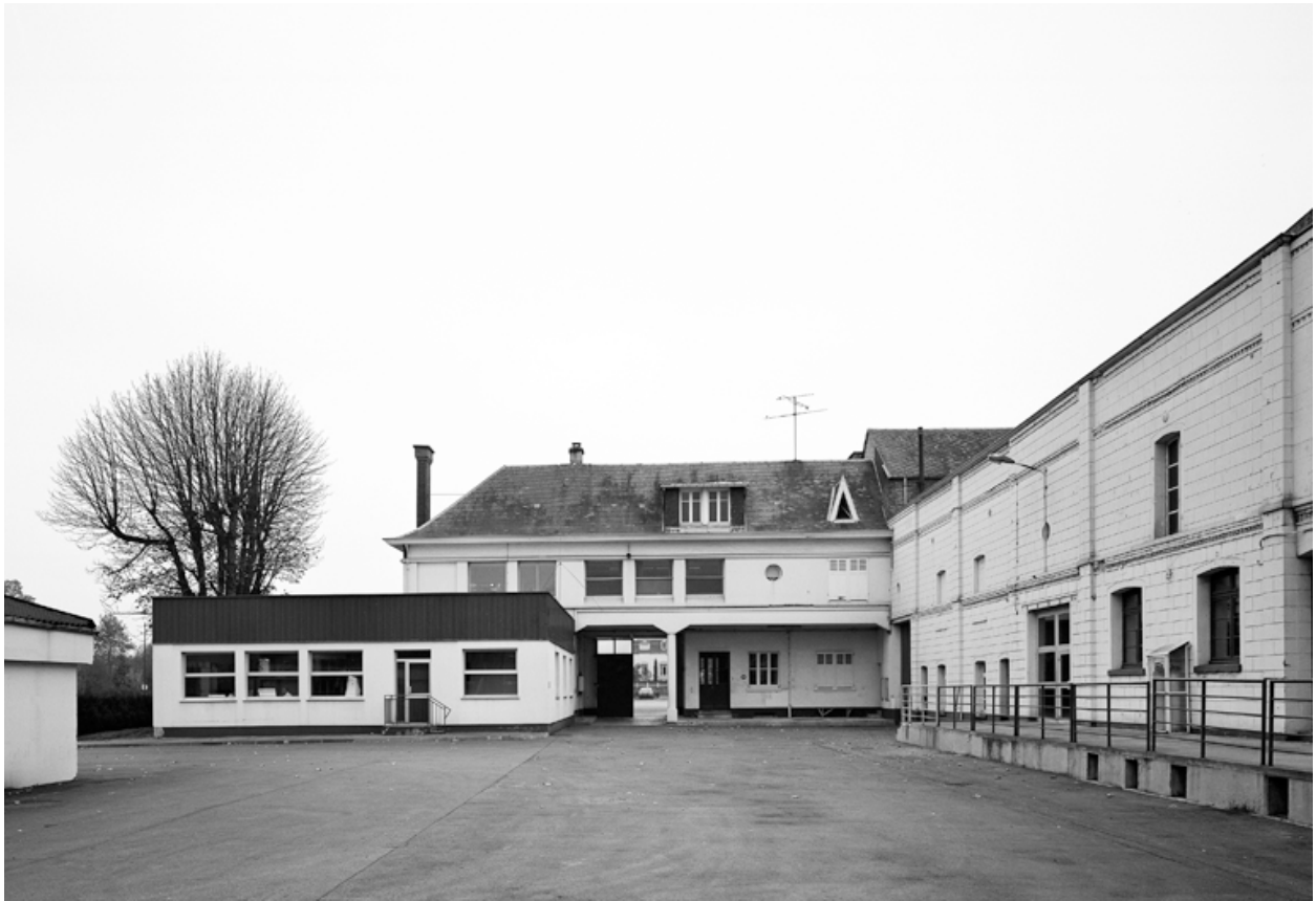
Elévation sur cour des bureaux.
