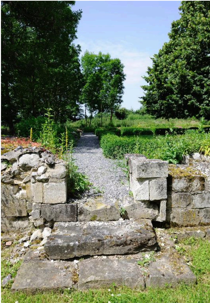
Vestige de mur et de porte d'accès au cloître.
