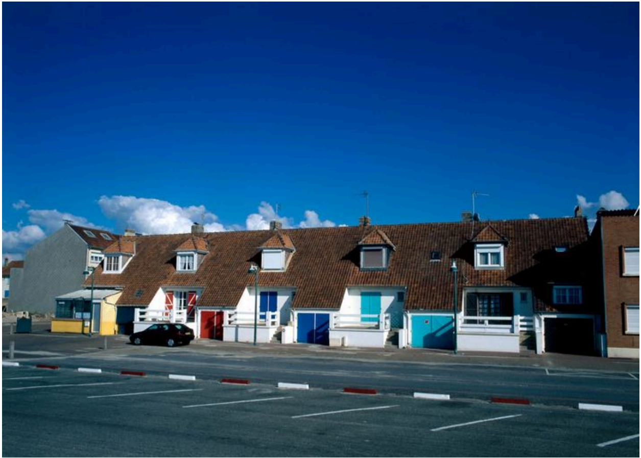
Ensemble de cinq maisons accolées, digue sud.
