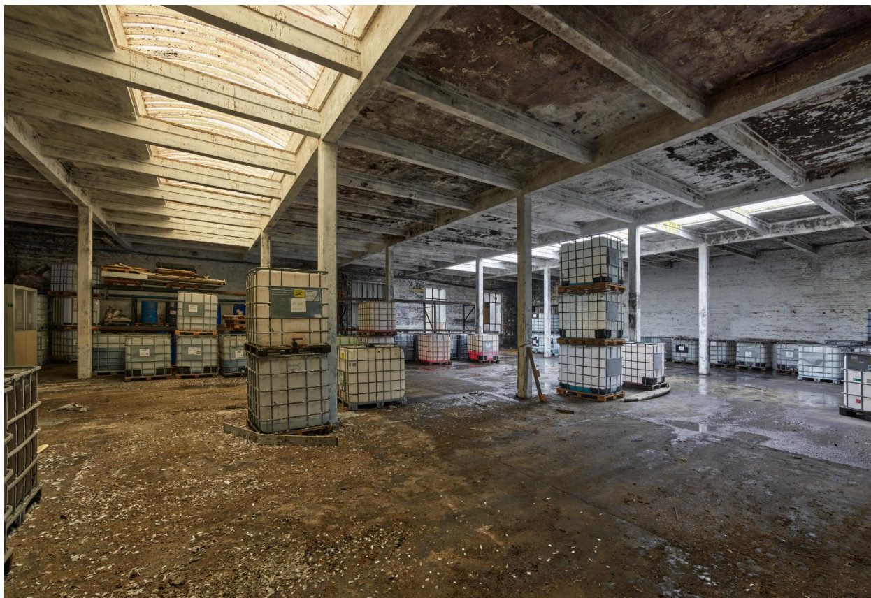
Intérieur du magasin (bas du bâtiment K), vue générale.
