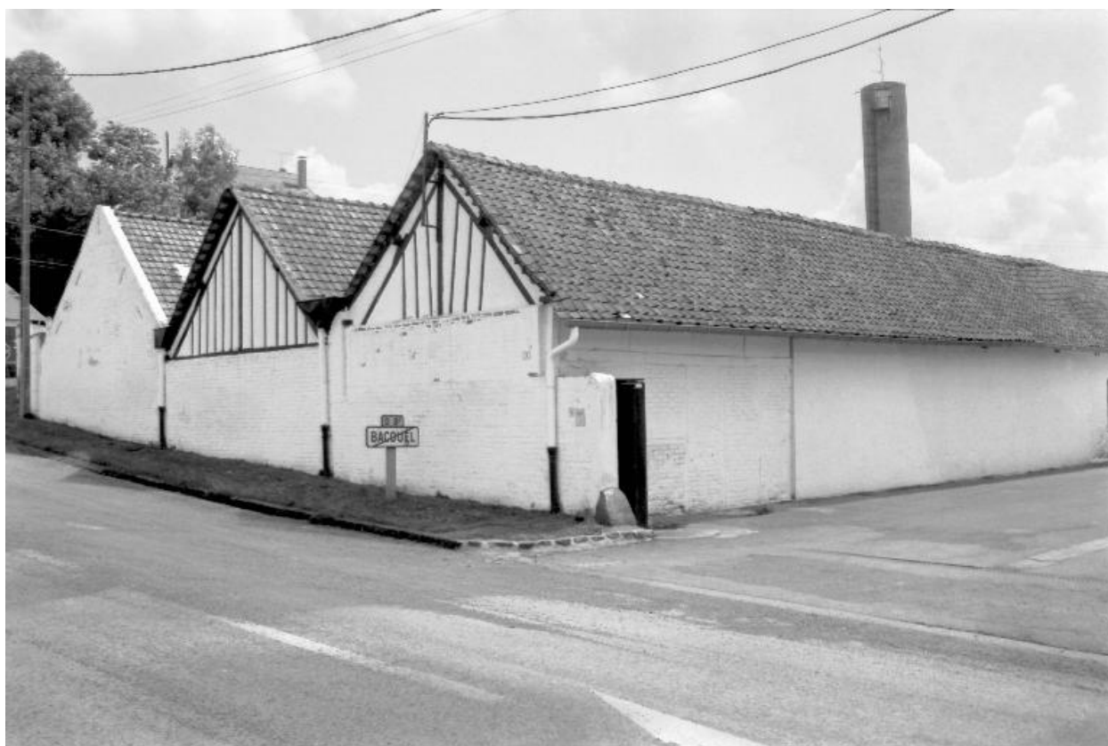
Détail flanc nord ouest.
