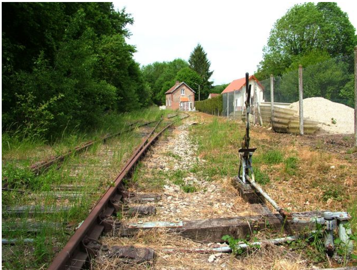
Vue partielle de l'ancienne ligne ferroviaire avec aiguillage et maison de garde-barrière.
