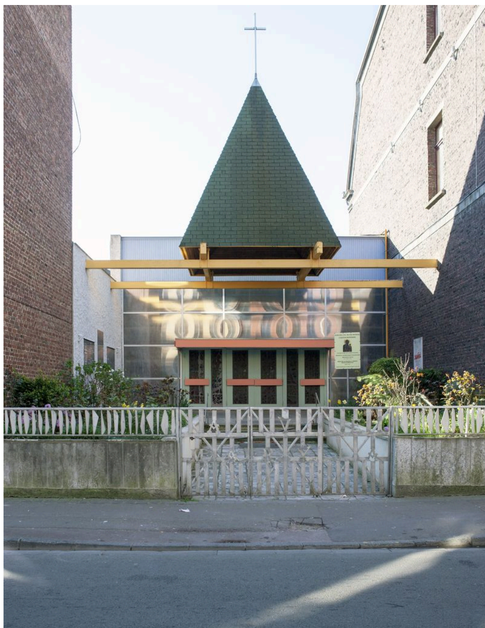
Élévation antérieure de la chapelle.
