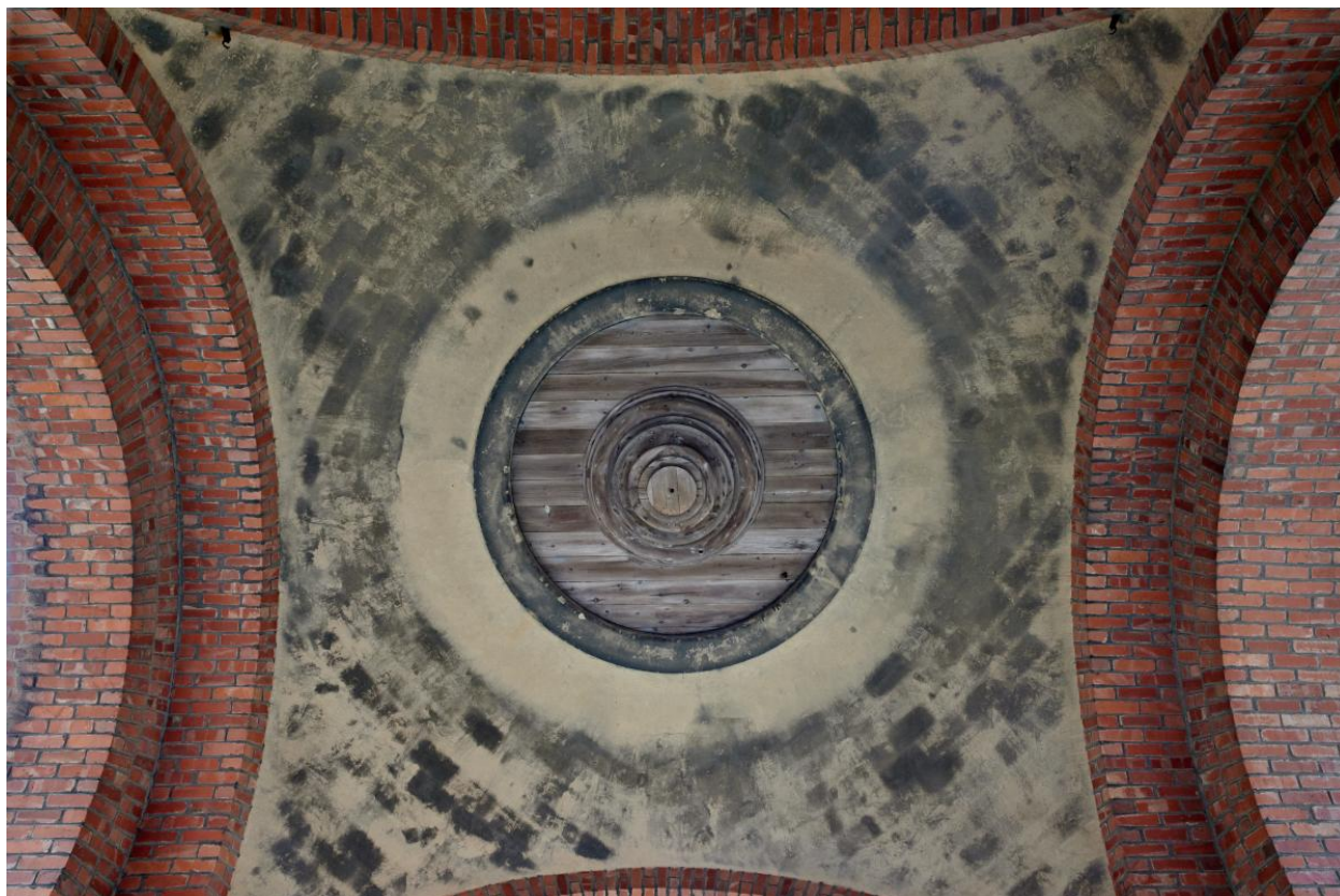
Voûte du porche.
