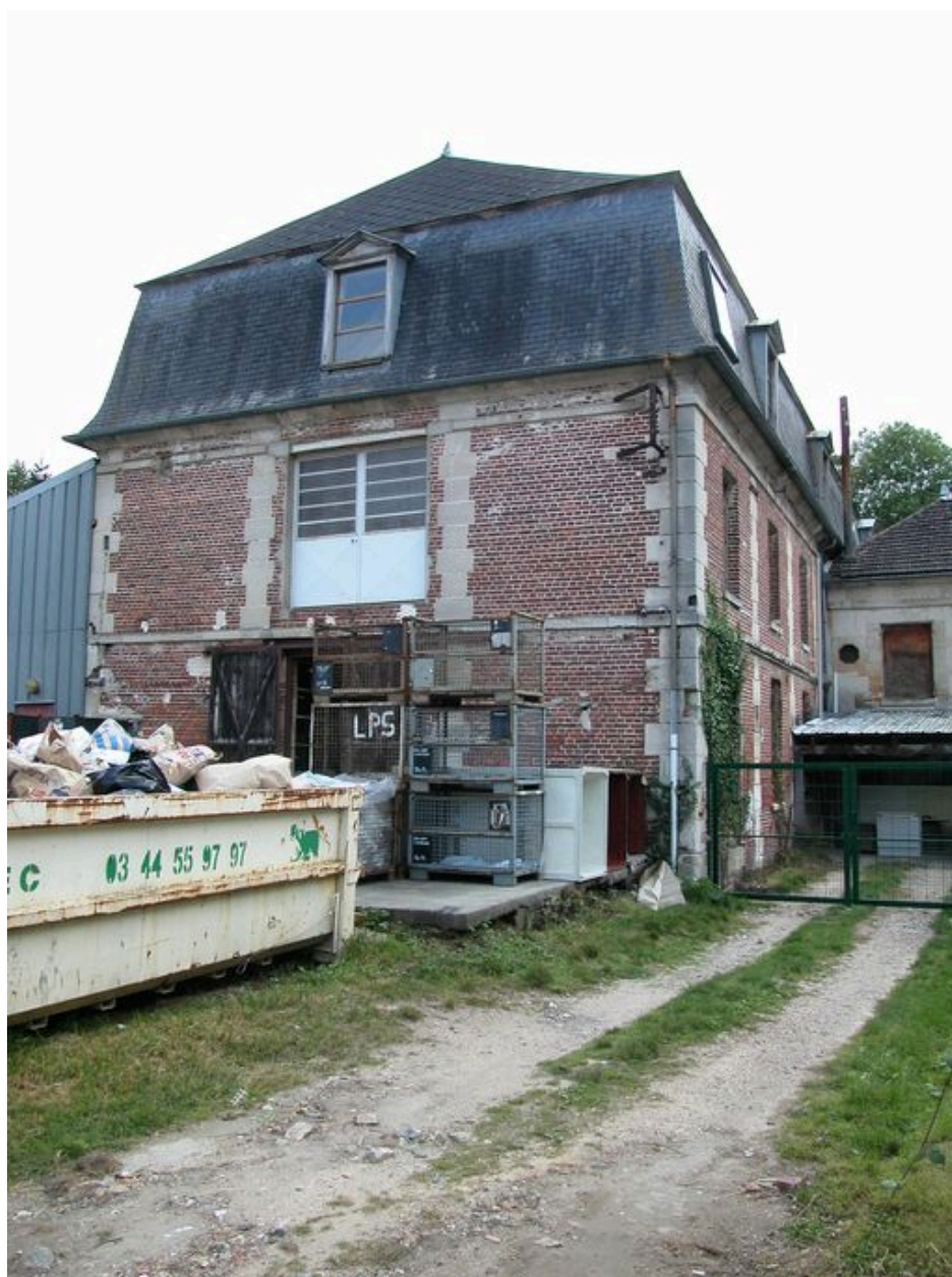
Pignon de l'extention en brique de la filature.
