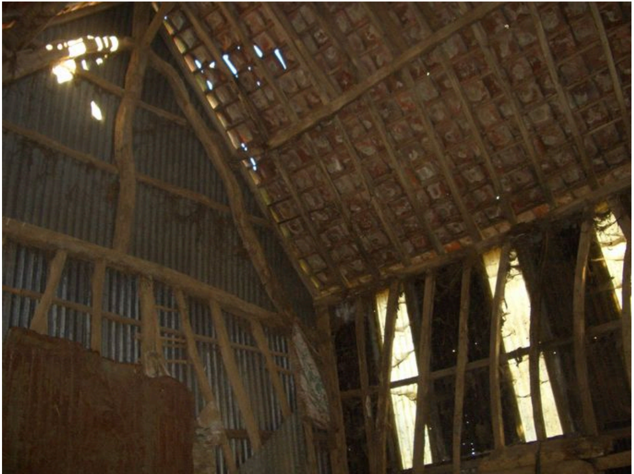
Vue intérieure de la grange.
