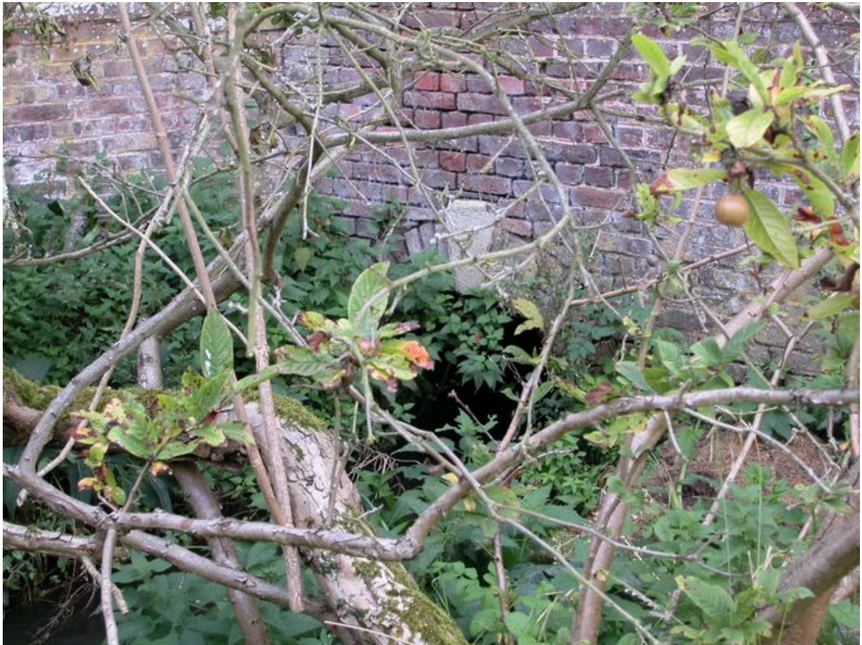
La sortie du canal de fuite.
