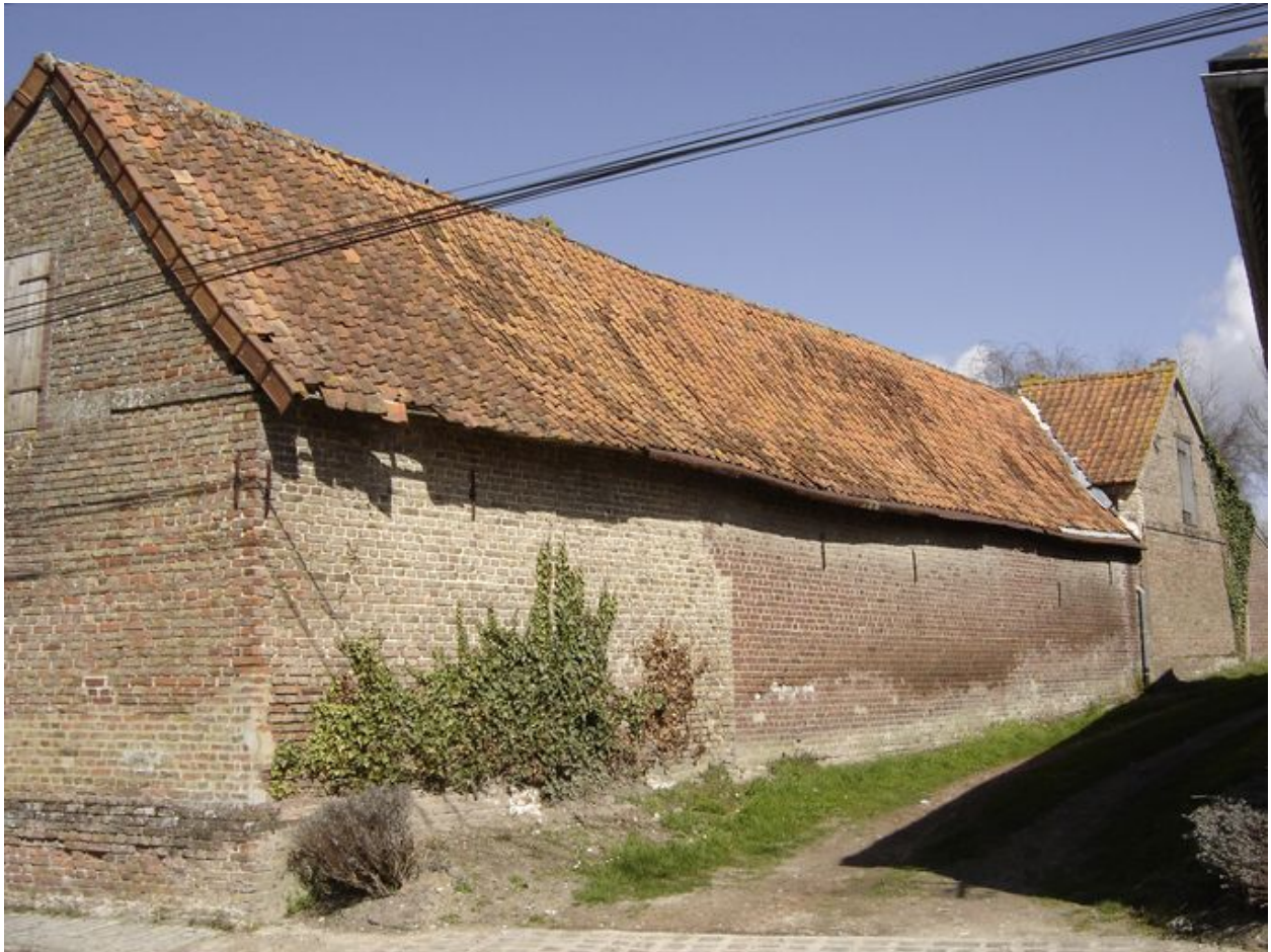
Vue extérieure des bâtiments situés à l'est de la cour.
