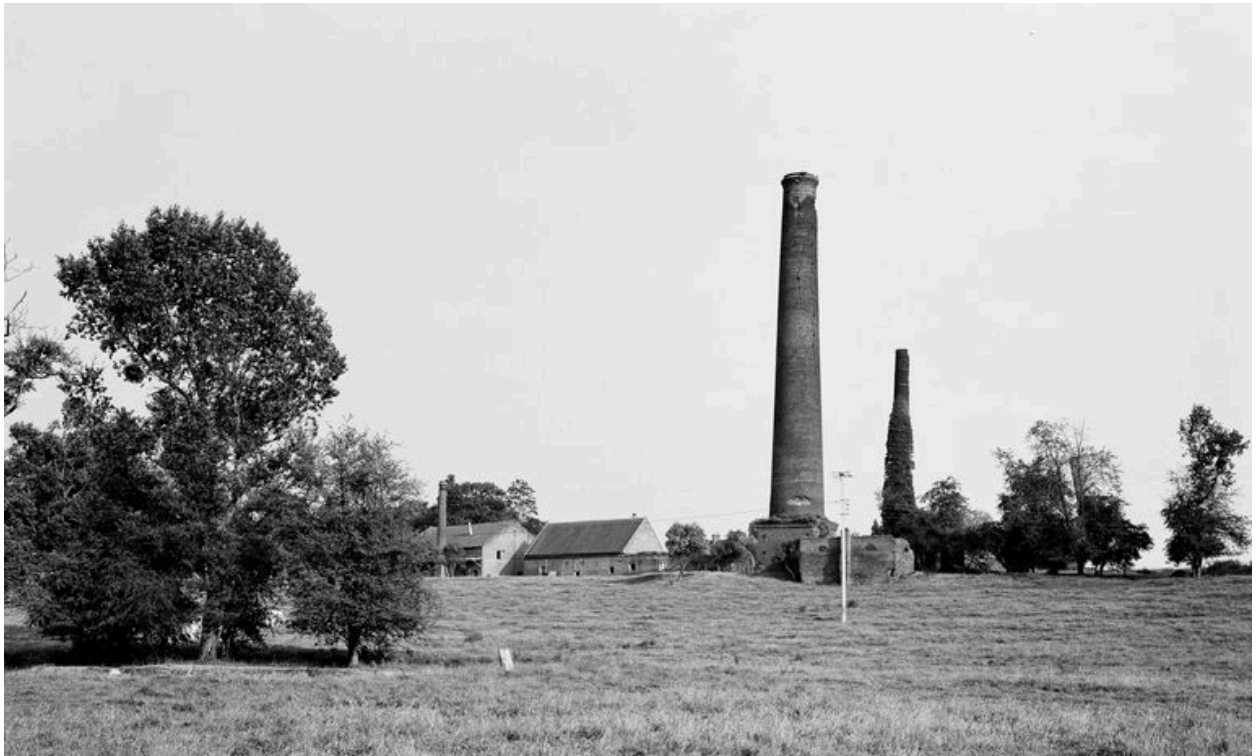
Vue générale nord.
