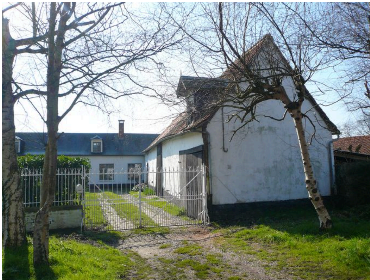
Vue de la grange.
