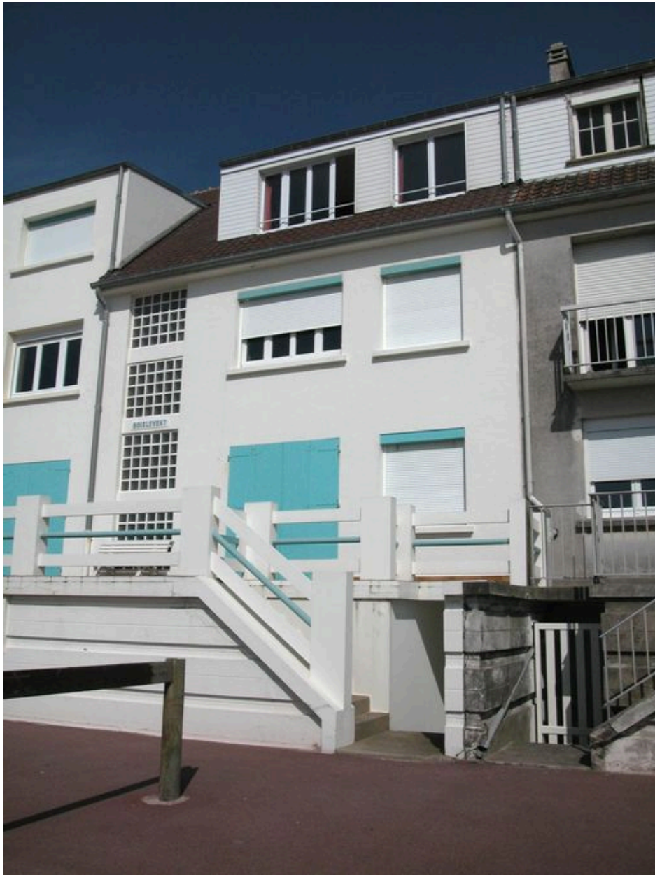
40 boulevard maritime sud (Boislevant), façade sur mer.
