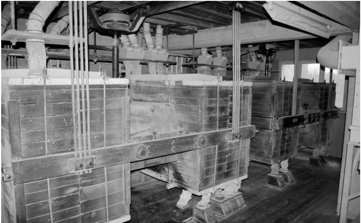
Vue intérieure du 2e étage de la minoterie, vue des planchisters.
