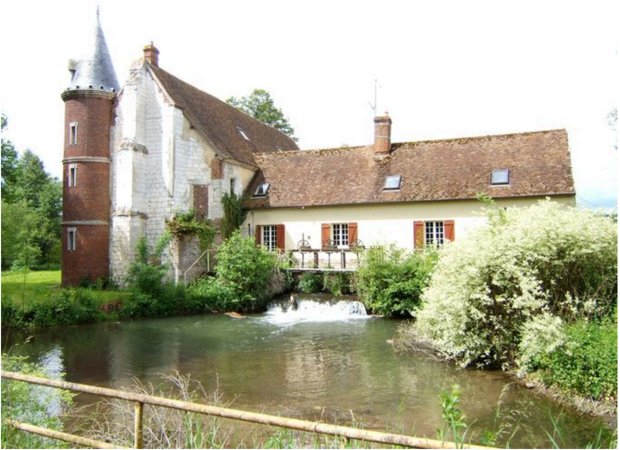
Vue générale, côté ouest.
