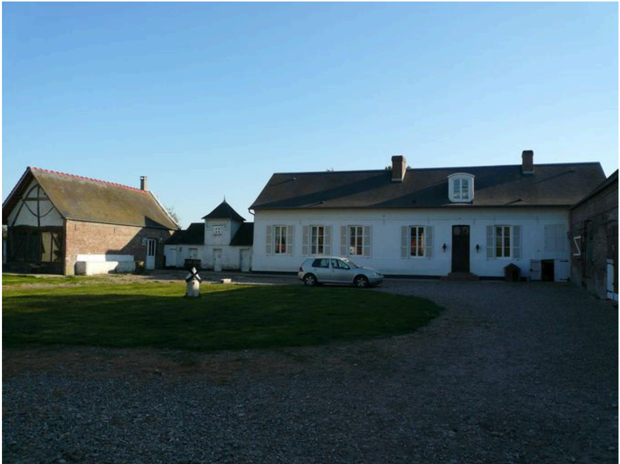
Vue du logis, des porcheries augmentées du pigeonnier ainsi que de la grange à gauche.
