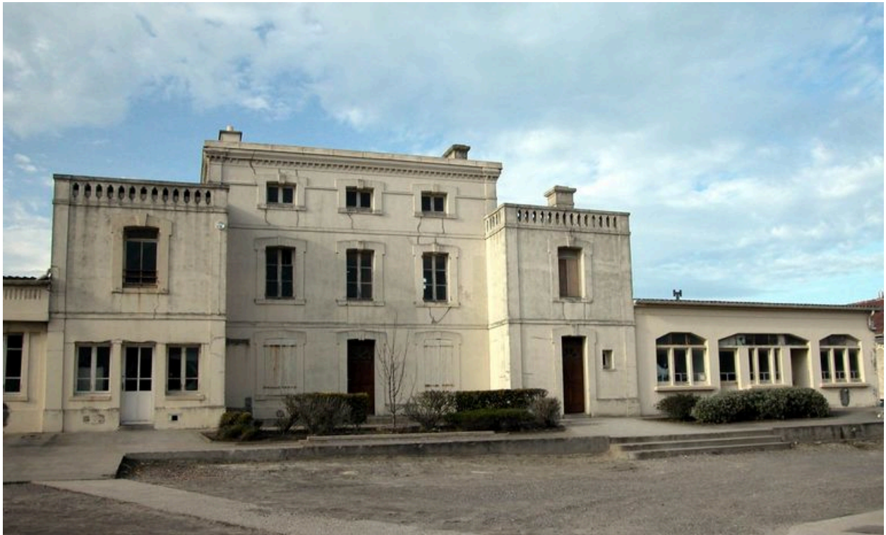
Vue d'ensemble avec une extension latérale.
