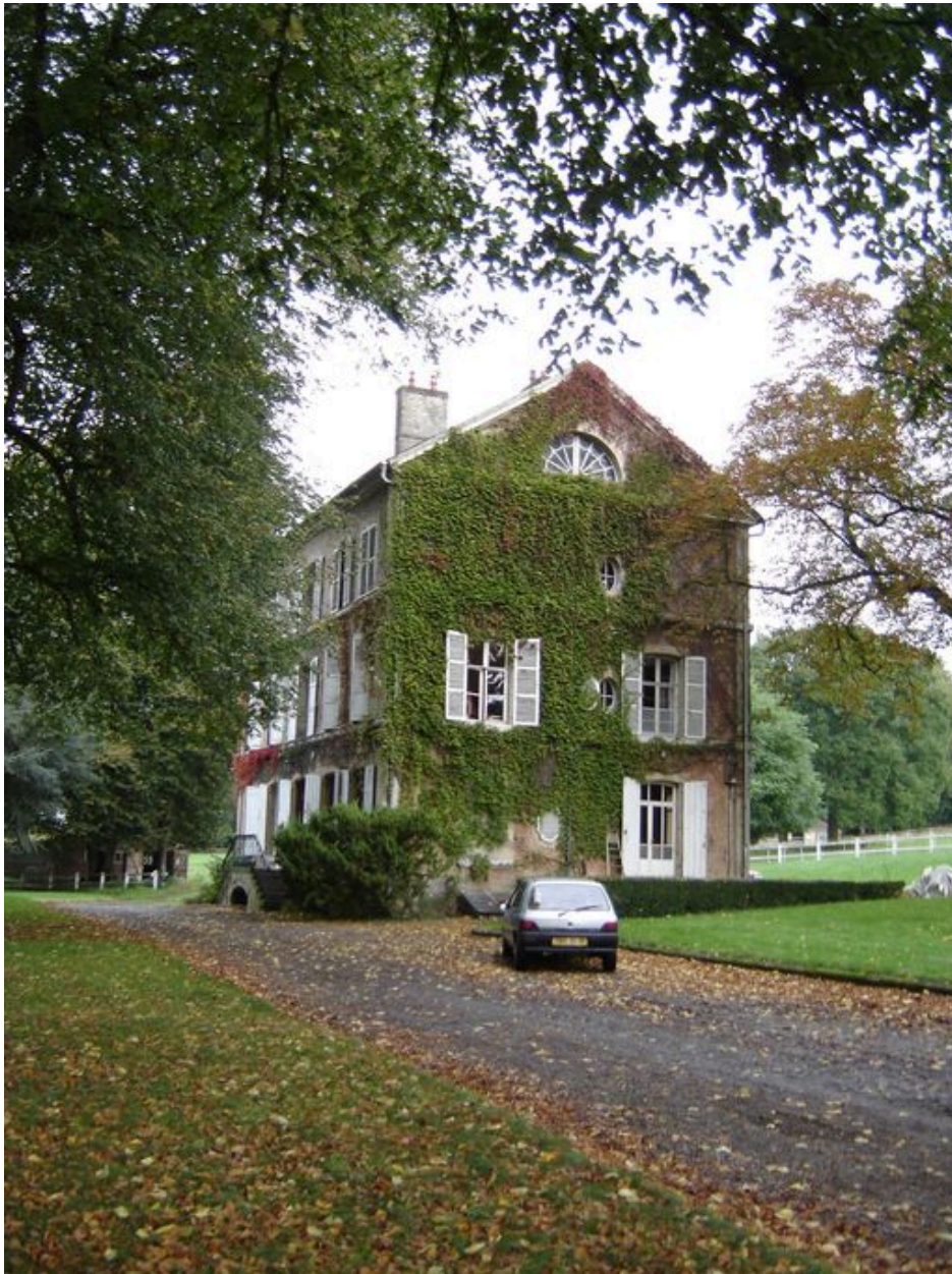
Vue du pignon est.
