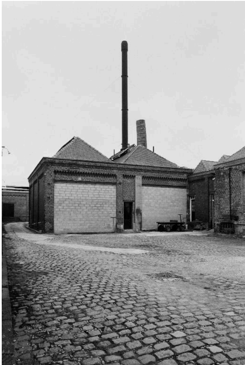
Chaufferie, flanc sud-est en 1987.
