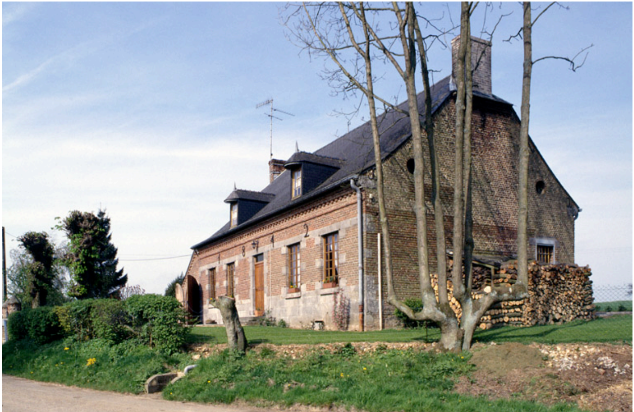
Vue de trois-quarts depuis l'est.
