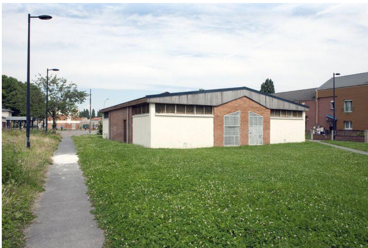
Élévation postérieure et flanc droit.
